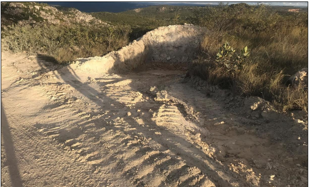
Figura 14: Modelo de caixa seca instalada na margem de estrada para contenção e diminuição da velocidade das águas.
