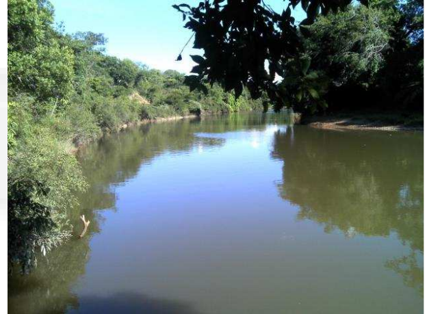
Foto 02. Local de construção de barramento no Ribeirão São Miguel
