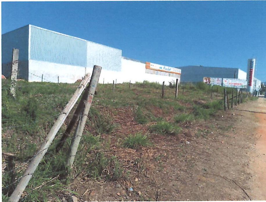
2- Foto do local: Vista Lateral
