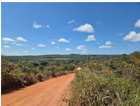
Foto 05. Visão geral do trecho
