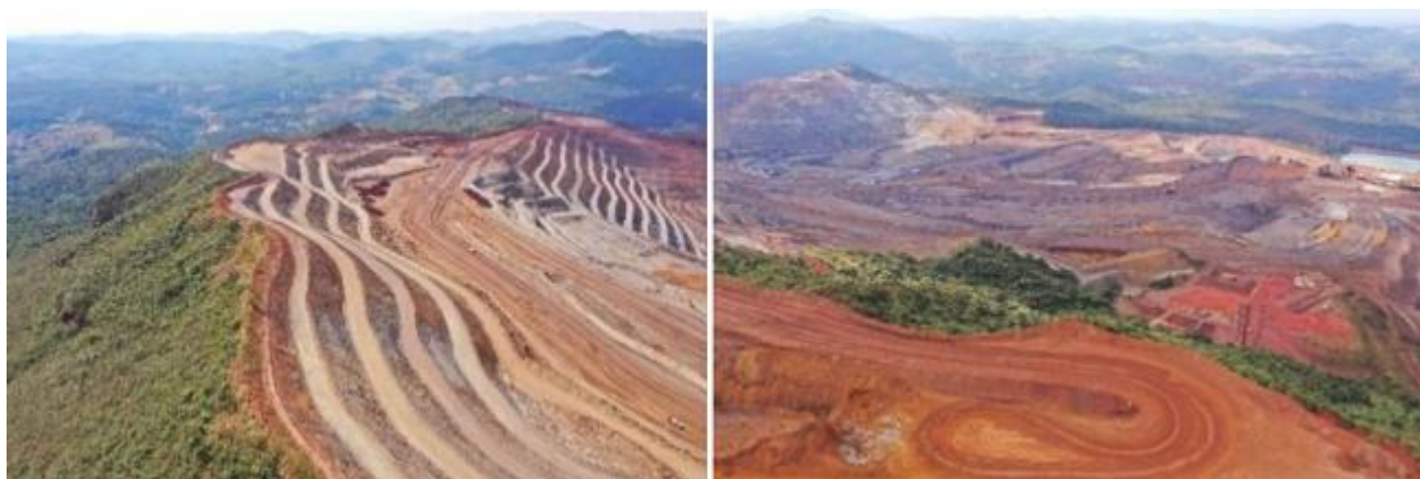
Figura 48 - Instalações operacionais e administrativas da mina Brucutu. Fonte: PIA,2024.
