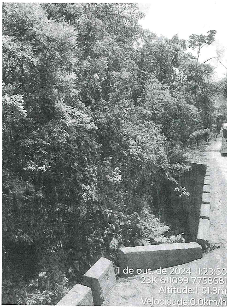
Foto 1: Vista da lateral da ponte a ser suprimida. Fonte: SEMAM,2024.
