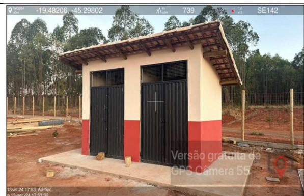
Foto 05. Depósito Temporário de Resíduos Sólidos
