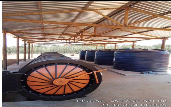
Foto 01. Galpão com autoclave e tanques
