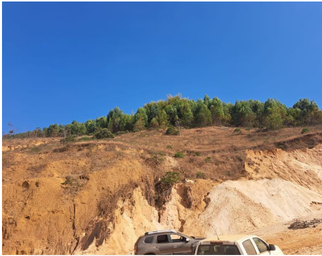
Foto 01 – Visão da área de cava à seco
