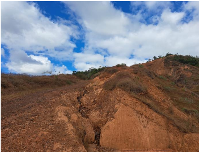
Foto 03: Acesso à área de extração.
