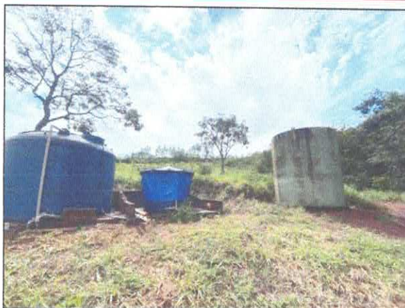
Figura 10: Pátio de estocagem a ser ampliado. Data: 25/01/2024.
