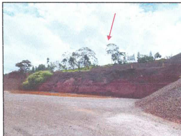
Figura 06: Pátio de estocagem a ser ampliado. Data: 25/01/2024.
