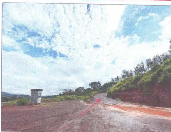
Figura 07: Acesso ao pátio de estocagem a ser ampliado. Data: 25/01/2024.
