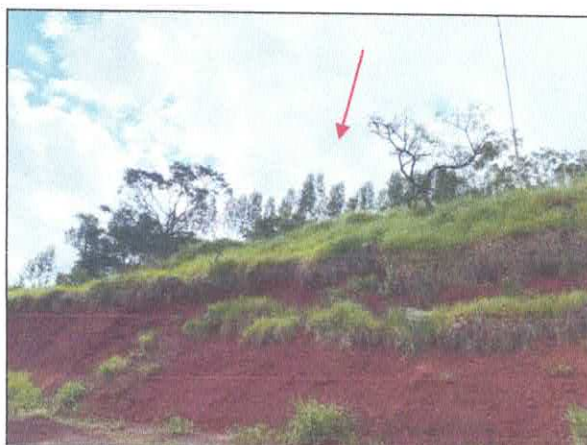
Figura 08: Pátio de estocagem a ser ampliado. Data: 25/01/2024.
