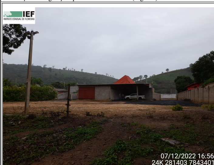
Figura 1: Construções existentes no lote que serão utilizadas pelo empreendimento.
