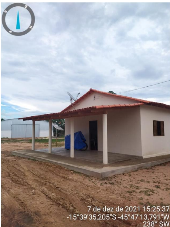
FOTO 01 – Sede recém construída.
