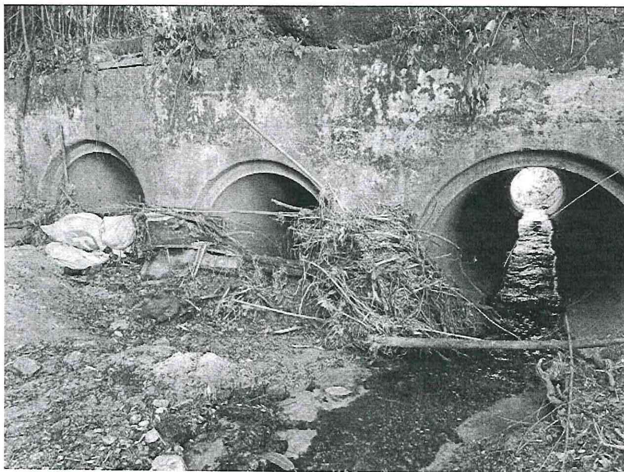
Figura 7: Bueiro MG-030. Fonte: Allpa Saneamento e Meio Ambiente (2023).
