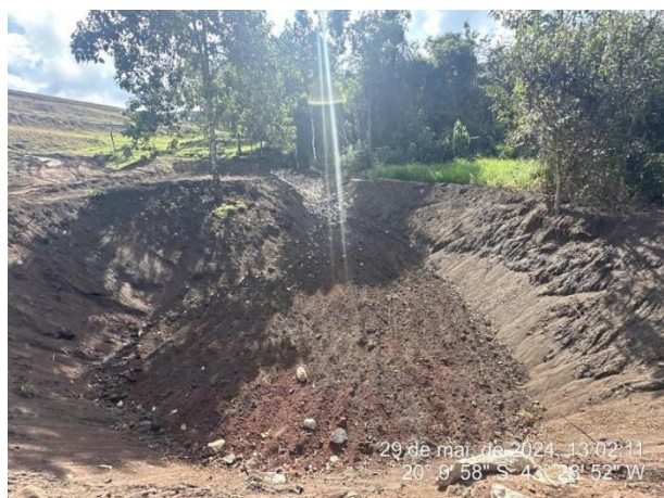
Foto 11: Sump localizado nas coordenadas UTM 23k 658730 / 7769411, implantado recentemente, para contenção de sedimentos e diminuição da energia de escoamento de água de chuva.
