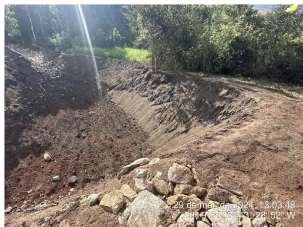
Foto 12: Detalhe do sump localizado nas coordenadas UTM 23k 658730 / 7769411. Pela imagem pode ser observado que se trata de obra recente, que necessita de implantação de cobertura vegetal para proteção das leiras que compõem a estrutura.
