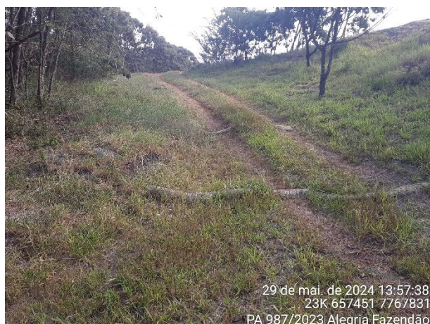
Foto 15: Bioretentores instalados cobertos com vegetação graminosa.
