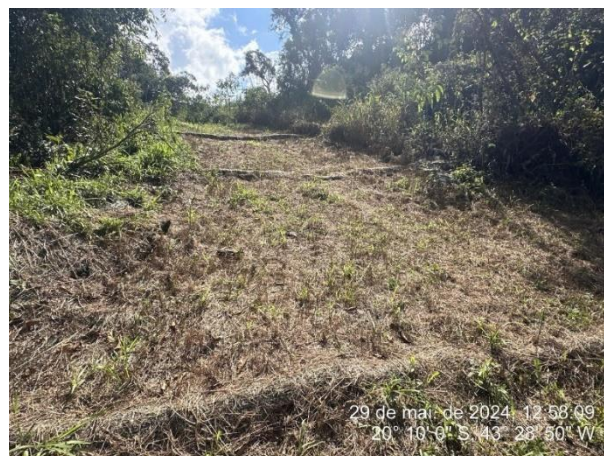
Foto 14: Bioretentores instalados no acesso a uma das praças de sondagem.
