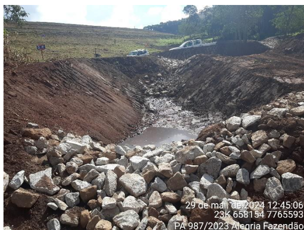
Foto 9: Detalhe de água acumulada no sump.
