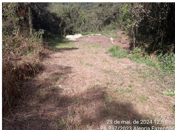
Foto 13: Bioretentores instalados cobrindo toda a superfície de solo exposto.
