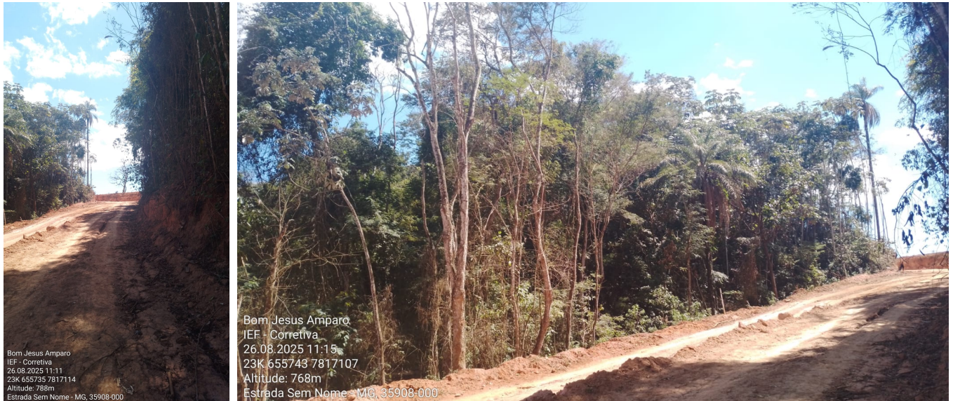
Intervenção na estrada embargada.
