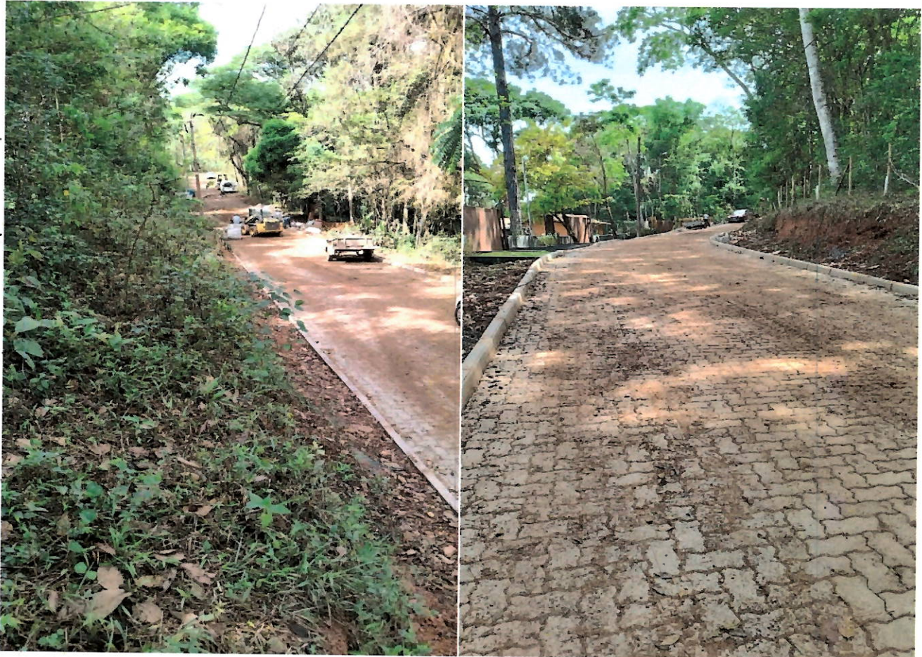
Imagem VI - Vista Parcial da Via Alameda Carcará - Via de Acesso
