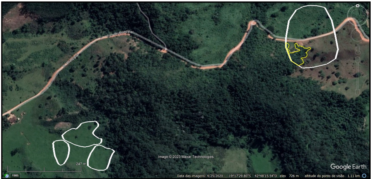
Figura 9 - Delimitação das áreas objeto de intervenção ambiental: área da jazida/frente de lavra, na qual ocorrerá supressão de vegetação nativa do bioma Mata Atlântica (em amarelo) e área de britagem, onde ocorrerá corte de árvores isoladas nativas vivas (área em branco, excluindo-se a delimitação em amarelo).
