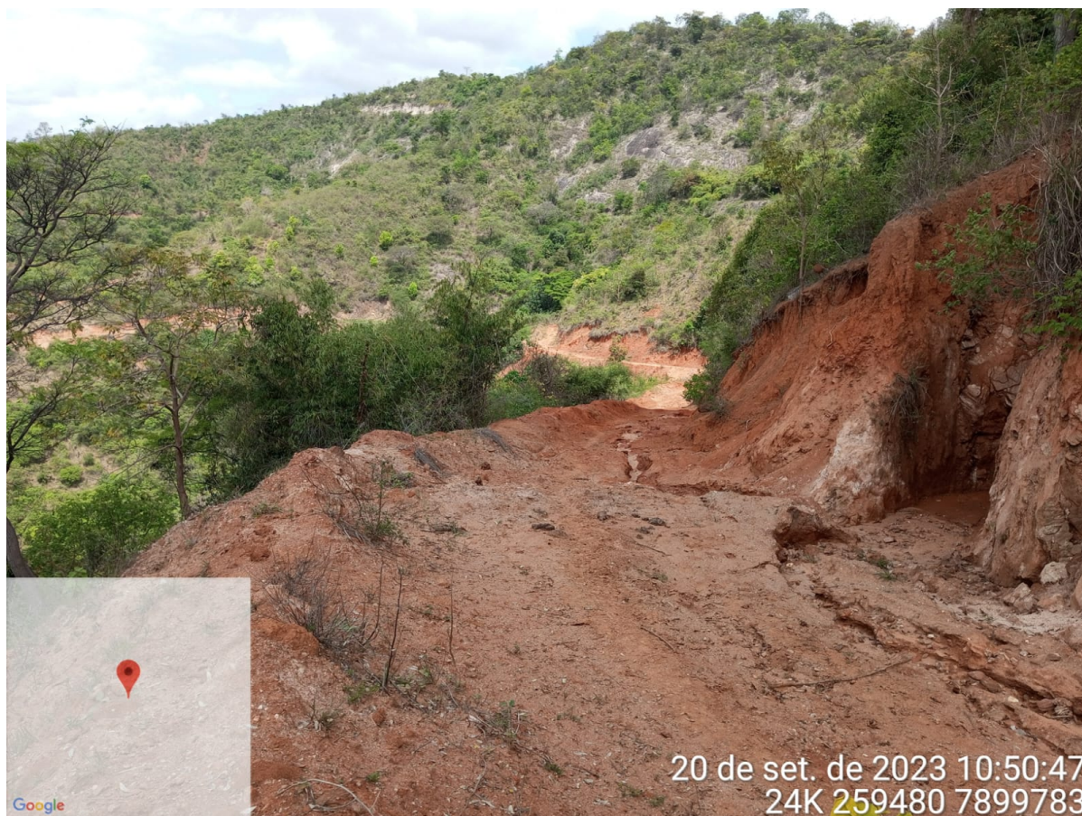
Imagem 5: Área de intervenção para abertura da estrada (área não autuada)
