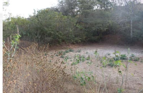
Foto 02. Bacia de contenção de sedimentos.
