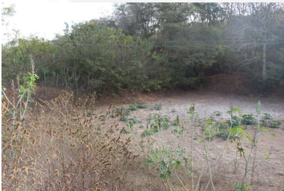
Foto 05. Bacia de contenção de sedimentos.
