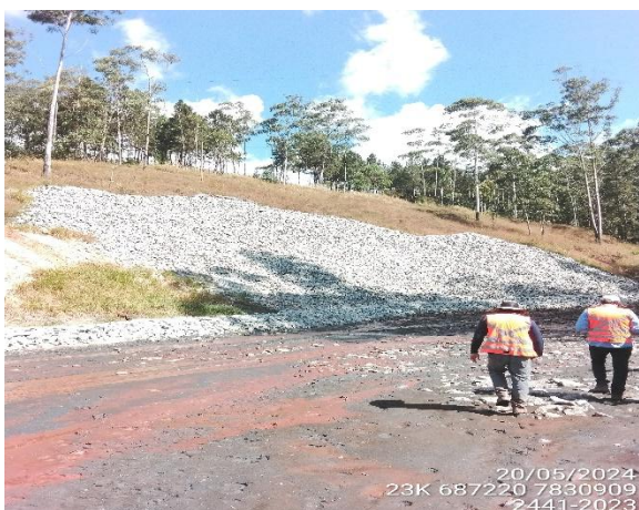
Foto 5: Blocos de rocha em talude para contenção de erosão e sedimentos.
