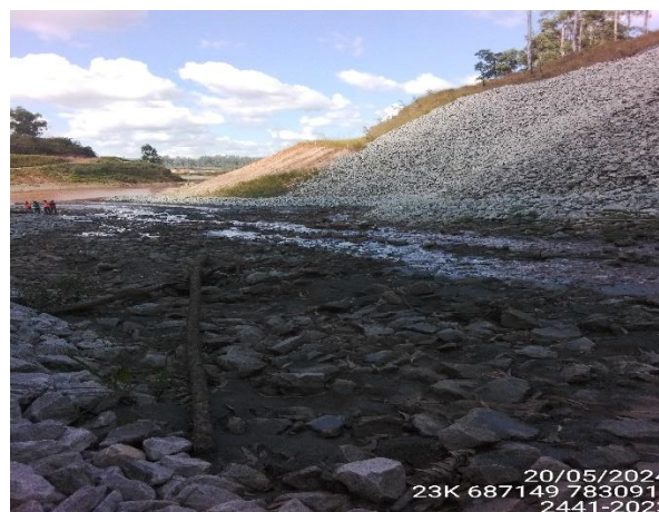
Foto 6: Blocos de rocha em talude para contenção de erosão e sedimentos
