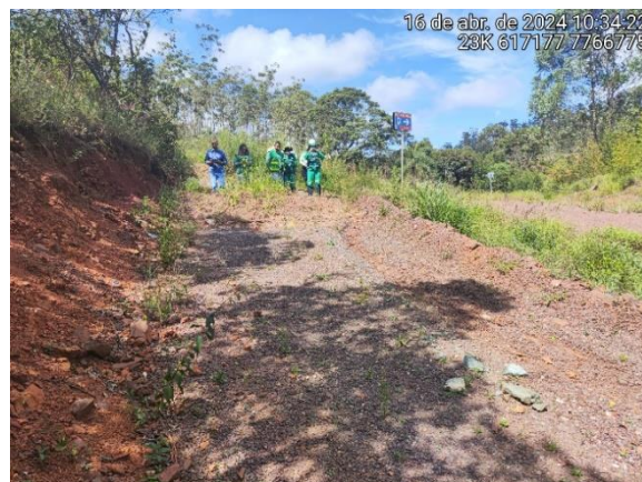
Foto 4: Parte do talude do acesso que apresenta indícios de processo erosivo.
