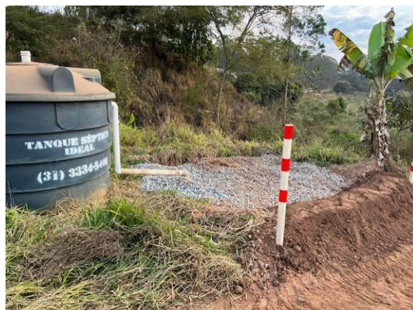
Foto 08. Fossa séptica com sumidouro.
