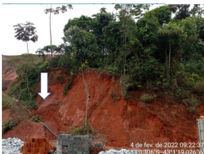
Figura 21. Área de intervenção evidenciando deslizamento de solo no talude.
