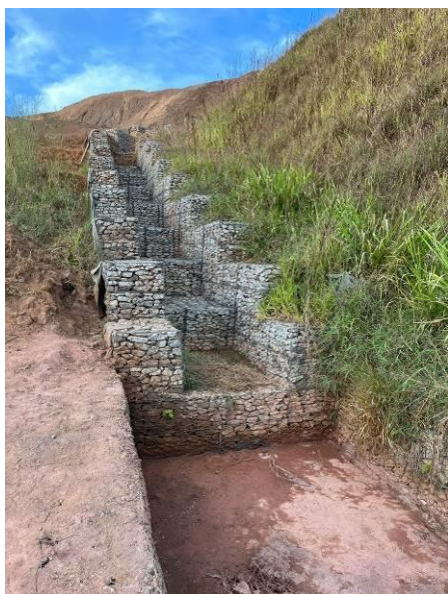
Foto 09. Escada dissipadora em gabião – Sistema de drenagem pluvial.
