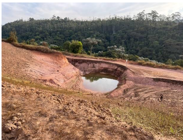
Foto 15. Sumps – bacias de contenção de sedimentos (drenagem pluvial).
