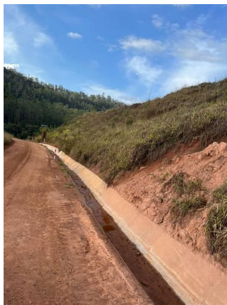
Foto 10. Canaleta de drenagem pluvial em concreto na base do talude, que se encontra em processo de revegetação.
