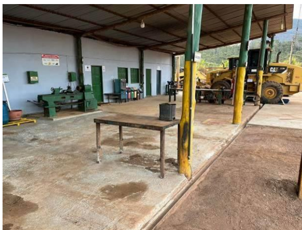
Foto 07. Oficina com piso impermeável e canaletas no entorno.
