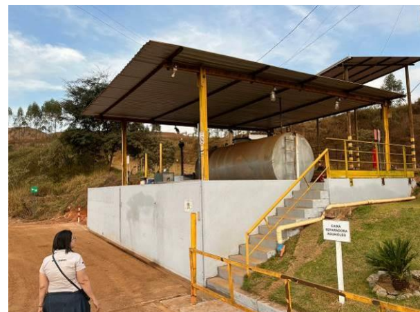
Foto 04. Ponto de abastecimento de 15m³ com as medidas de controle e mitigação.
