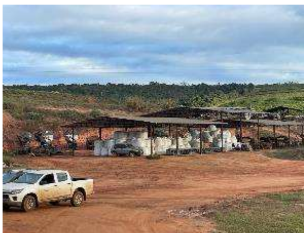
Foto 03. Galpão para depósito de insumos e equipamentos agrícolas.
