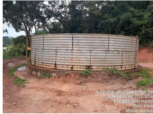
Foto 20: Tanque de espera para bombeamento de água.
