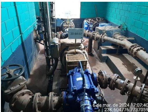
Foto 21: Casa de bombas que conduzem a água do tanque de espera para o tanque de água nova através da adutora.
