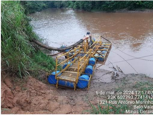
Foto 19: Ponto de captação de água no rio Paraopeba através de sistema de bomba flutuante.
