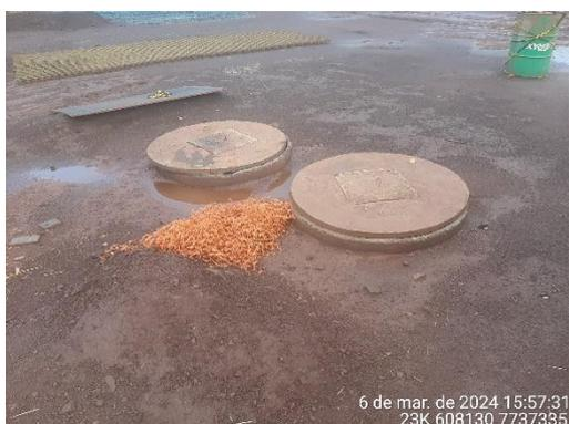
Foto 33: CSAO que recebe efluente da área de alvenaria em que ficam contidos os geradores e o tanque de combustível.
