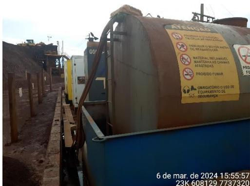
Foto 31: Caixa de contenção metálica do tanque de combustível.
