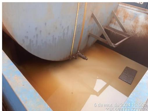
Foto 32: Borra de óleo e água de chuva dentro da caixa de contenção metálica.
