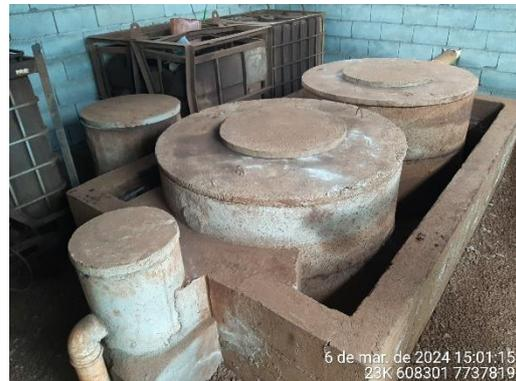
Foto 58: CSAO Final que recebe os efluentes das CSAO da oficina e lavador de veículos e do ponto de abastecimento.
