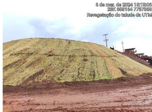
Foto 6: Talude sendo revegetado próximo a UTM.
