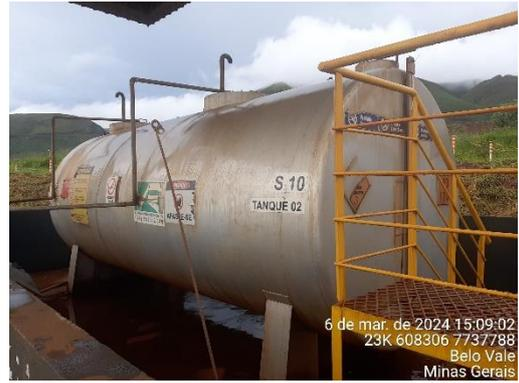
Foto 26: Tanque de 30.000L contido em estrutura de alvenaria impermeável.
