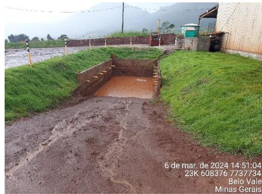
Foto 42: Baía de sedimentação do efluente proveniente da oficina e lavador de veículos.
