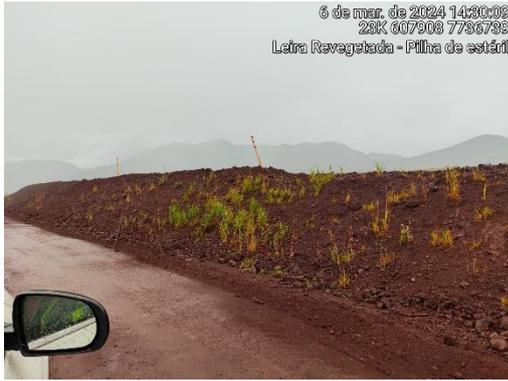
Foto 7: Talude na pilha de estéril revegetado necessitando de manutenção e readequação.
