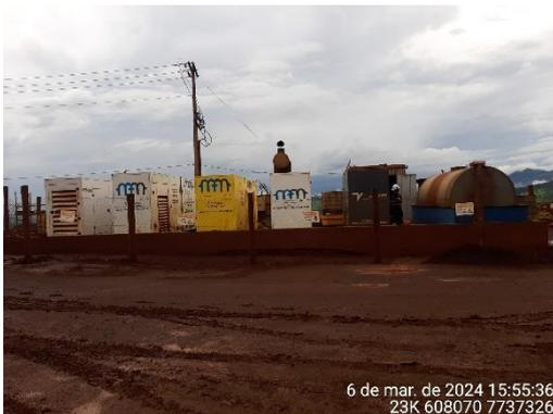
Foto 29: Geradores e tanque de combustível de 10.000L para fornecer energia para UTM e estruturas associadas.
