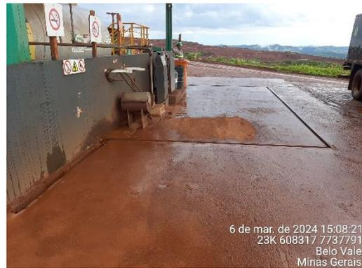
Foto 24: Pista e bombas cobertas circundadas por canaletas de drenagem de efluentes.
