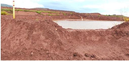
Foto 13: Baia (cava ou caixote) funcionando como reservatório de água de chuva.
