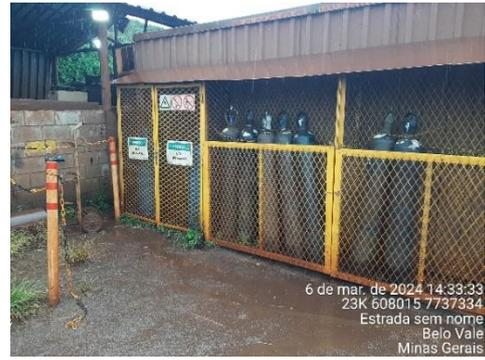
Foto 62: Local de armazenamento de gases.
