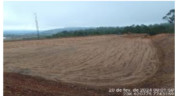
Foto 6: Área 3 – Terraplanagem já adiantada (Foto fornecida pela Vale).
