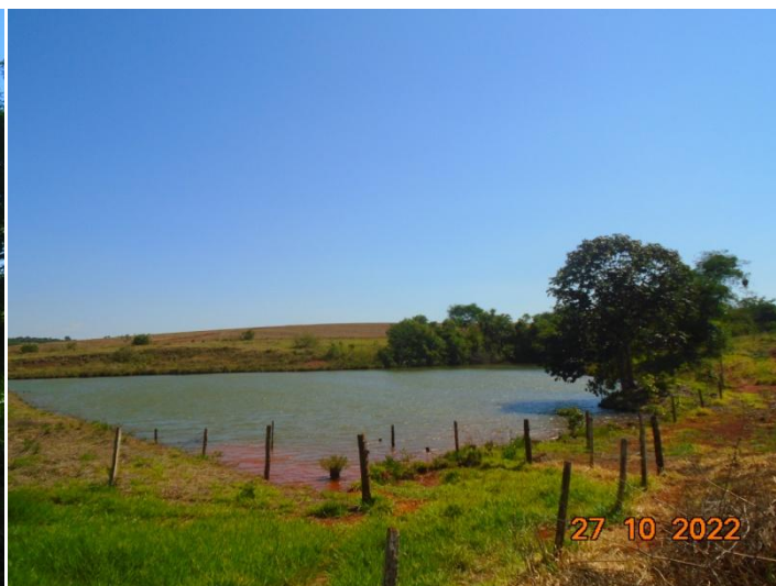
Figura 04: Ampliação de barramento já existente
