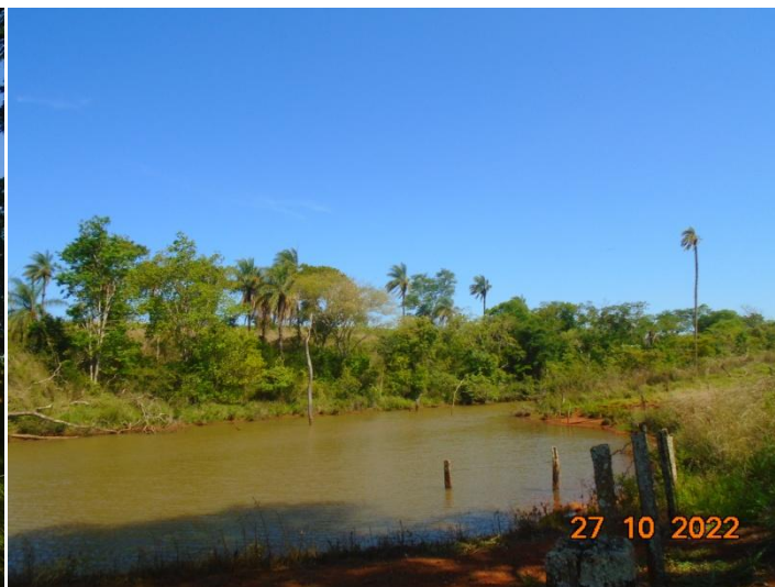
Figura 02: Ampliação de barramento já existente
