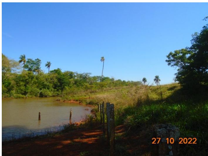
Figura 03: Ampliação de barramento já existente
