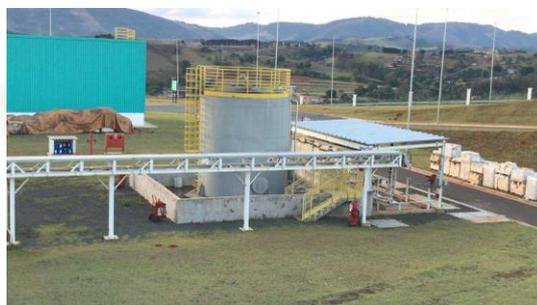
Foto 6: Tanque de diesel
