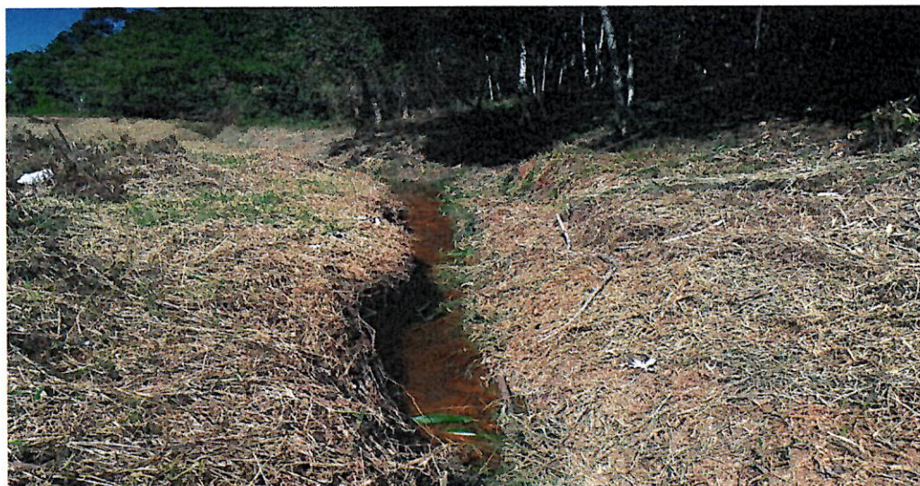
Figura 08: Outro trecho do córrego com calha regular. Foto tirada 03/05/2021
