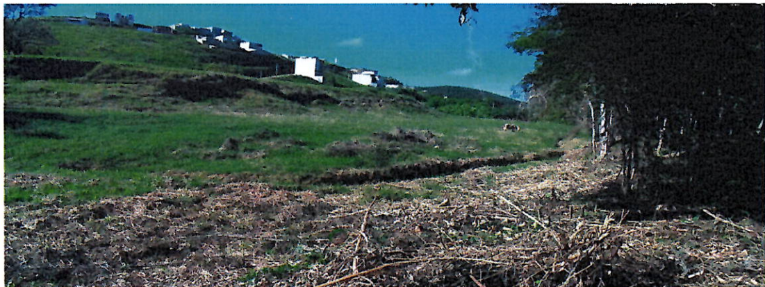
Figura 04: Vista geral da área limpa - Foto tirada no dia 03/05/2021
