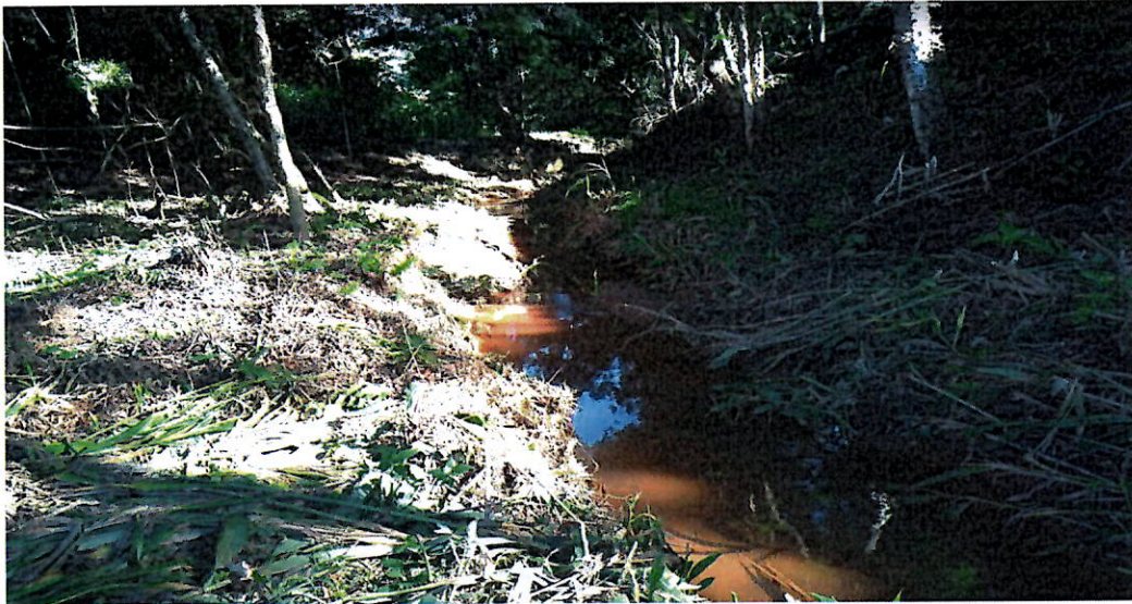
Figura 11: Final da retificação, destaca-se a calha regular, margem estabilizada e qualidade da água, sem sequer a presença de sedimentos em suspensão. Foto tirada 03/05/2021.
