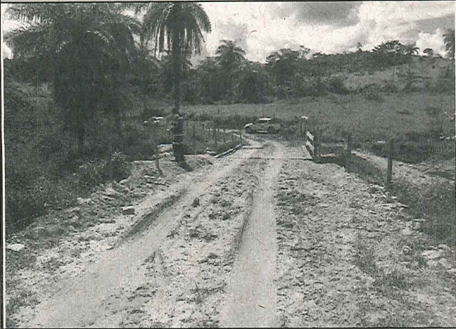
Foto 01: Ponte na Fazenda do Morais.
